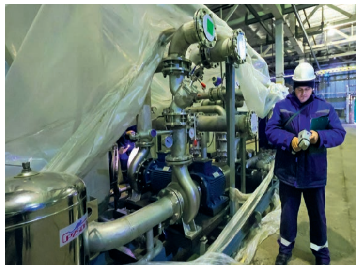
На заводской базе оборудования идёт приёмка насосного модуля для пластинчатого охладителя
